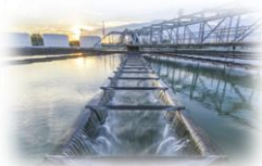
Tratamiento de aguas
